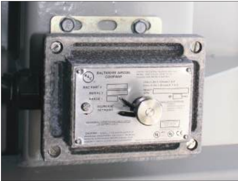
振动切断开关
