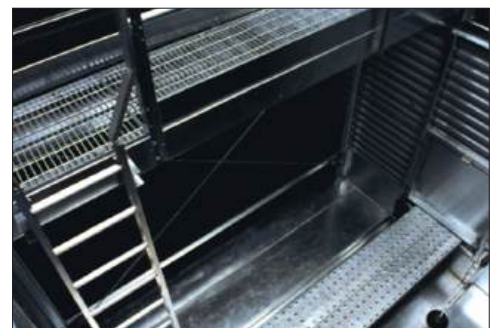
内部爬梯、检修平台及内部检修走道
