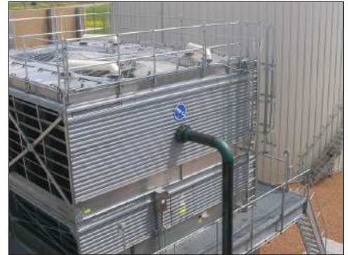
配以FRP面板，且结构升级后的冷却塔
