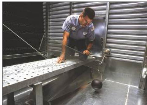
机械式水位控制组件
