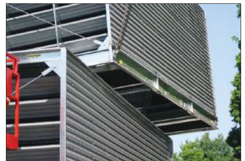
吊装指导确保正确安装
