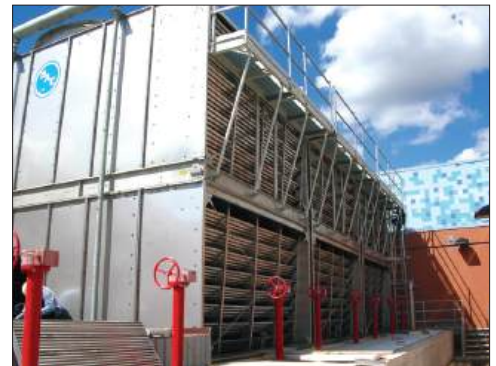
外部检修平台
