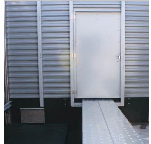
内部检修走道及超大检修门
