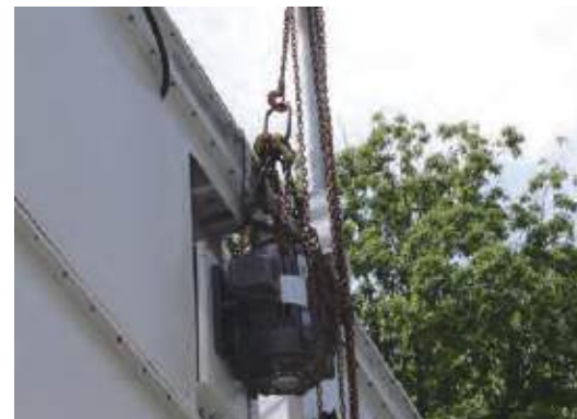
电机更换吊架
