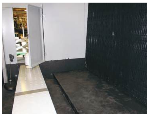
内部检修平台
