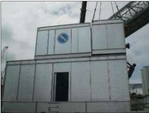
吊装指导确保正确安装
