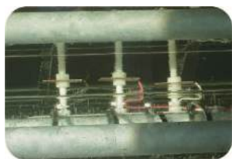
图 7-4 冰厚度控制器
